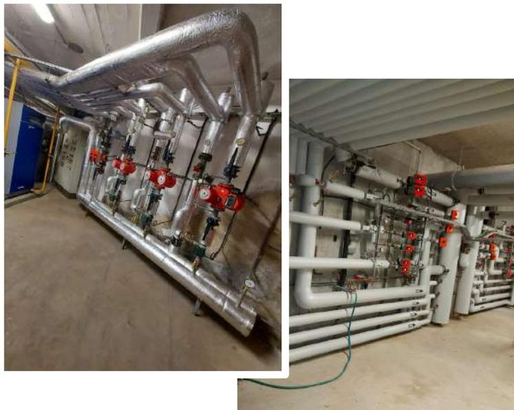
**À savoir** : Isolation des réseaux d'eau chaude sanitaire et de chauffage pour réduire les pertes de chaleur.
